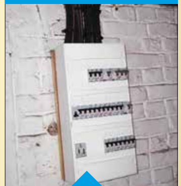
Mises aux normes d'un logement dégradé
