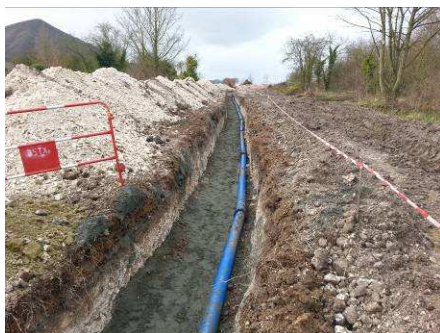
Pose de réseau en tranchée ouverte
