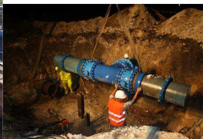
Raccordement de nuit sur réseau dn 500 mm
