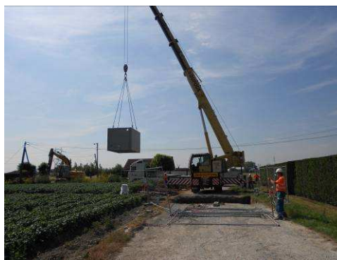
Pose du génie civil d'une station de surpression
