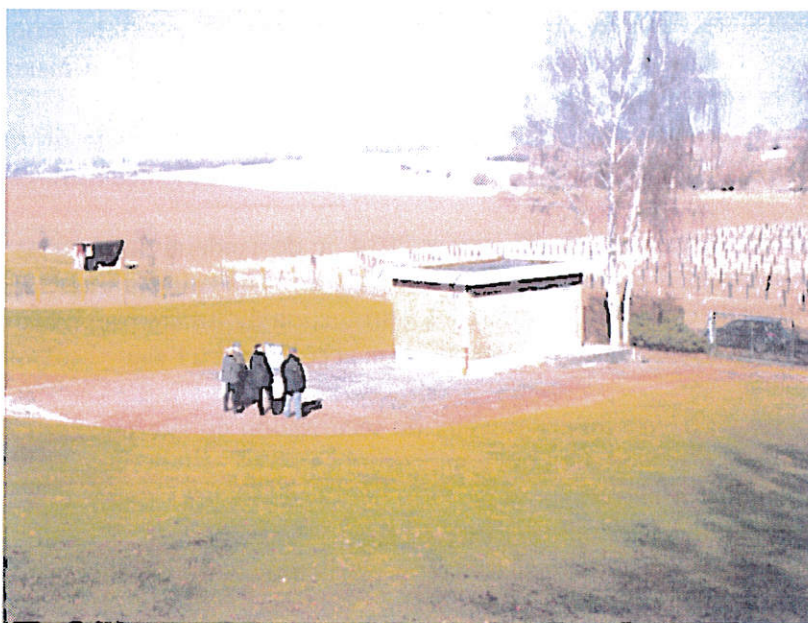
Photo a: Le captage AEP et son local technique à proximité
