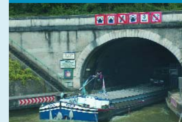
Péniche sortant du souterrain de Ruyaulcourt
