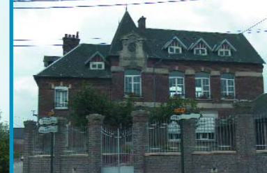
Mairie de Ruyaulcourt
